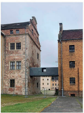
Zellenbau Verbindungsbau eigenes Foto
