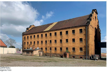
Zellenbau eigenes Foto
