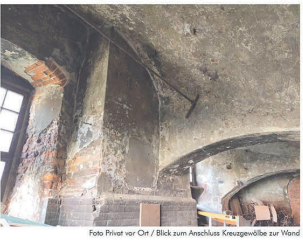
Foto Privat vor Ort / Blick zum Anschluss Kreuzgewölbe zur Wand
